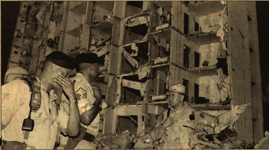
Zerstörte Unterkunft auf der US-Basis Dhahran
